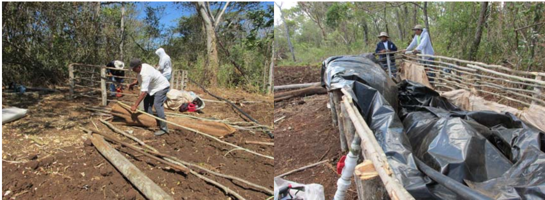
La construction d'un réservoir d'eau
